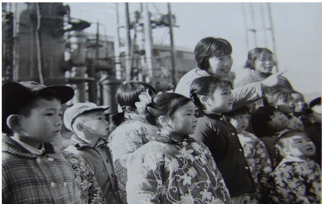
1978年，驻涟水县部队托儿所的小朋友在老师带领下到化肥厂扩建工地参观，淮安市档案馆藏，档号：D018-1978-003-0023-0046
